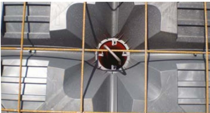
Für besondere Situationen, in denen die Kombination aus Lasten und sehr langen Rohren besonders schwierig ist, ist es ratsam in die Rohre Eisenelemente (Leisten/Gabeln aus Stahl) einzufügen, um die Stabilität der Betonsäule auch unter dynamischen Belastungen aufrechtzuerhalten.
